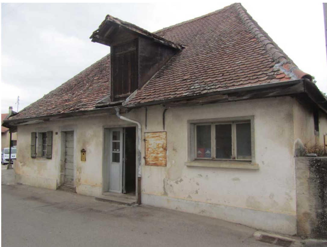
Laiterie du hameau de la Russille. Très belle forme générale malgré l'état moyen du bâtiment qui doit toujours servir de local de coulage.
