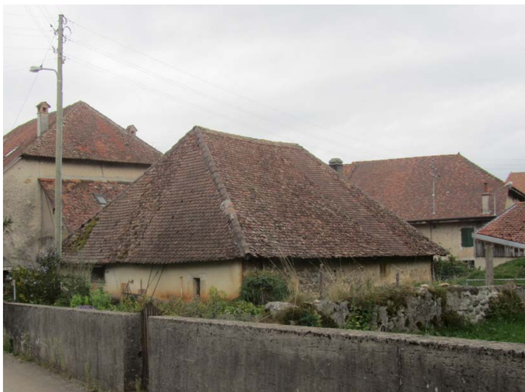
Une laiterie style chalet d'alpage, construite probablement dans le courant du XIXe siècle. Il semblerait que la société de laiterie ou de fromagerie du village ait été constituée en 1814.
