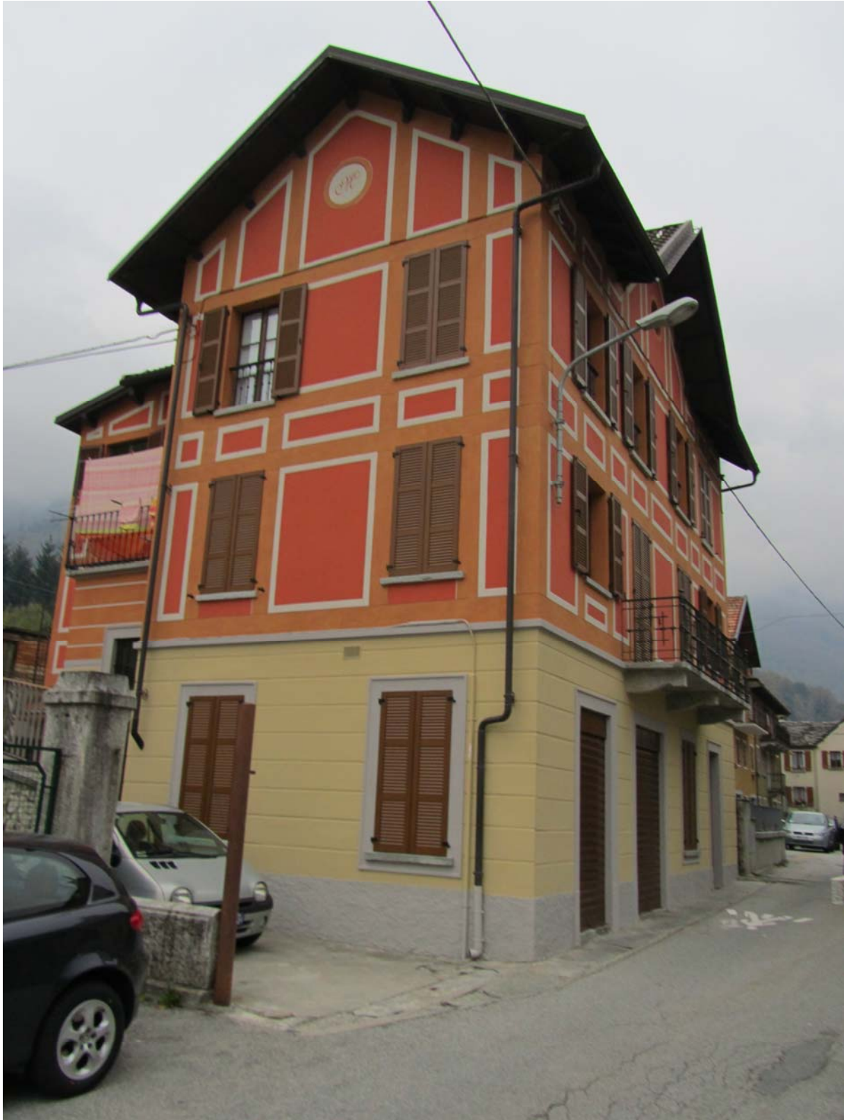
Une belle restauration pour cette maison élégante, témoignage d'une époque probablement touristique.
