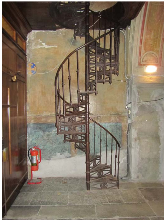
Escalier métallique conduisant à la galerie, style post art nouveau.
