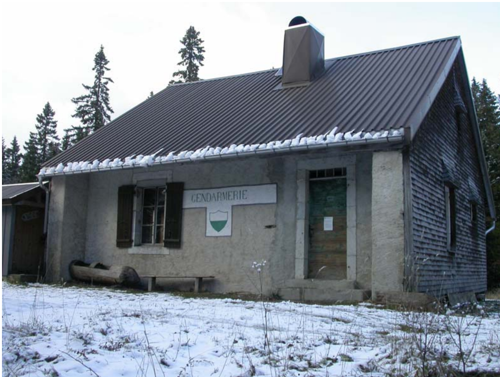
Le Poste des Mines en 2009.
