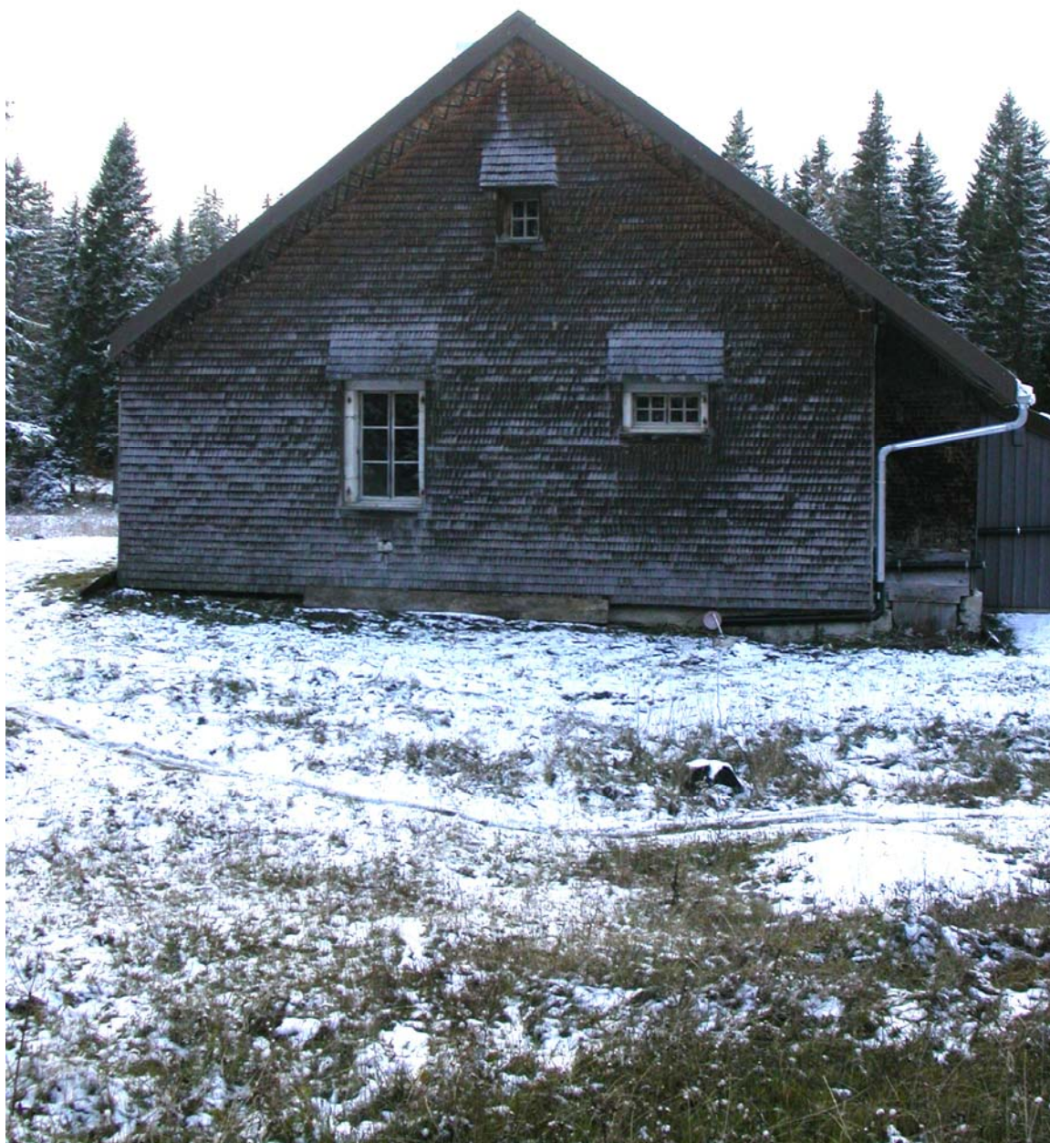
La façade à bise du Poste des Mines
