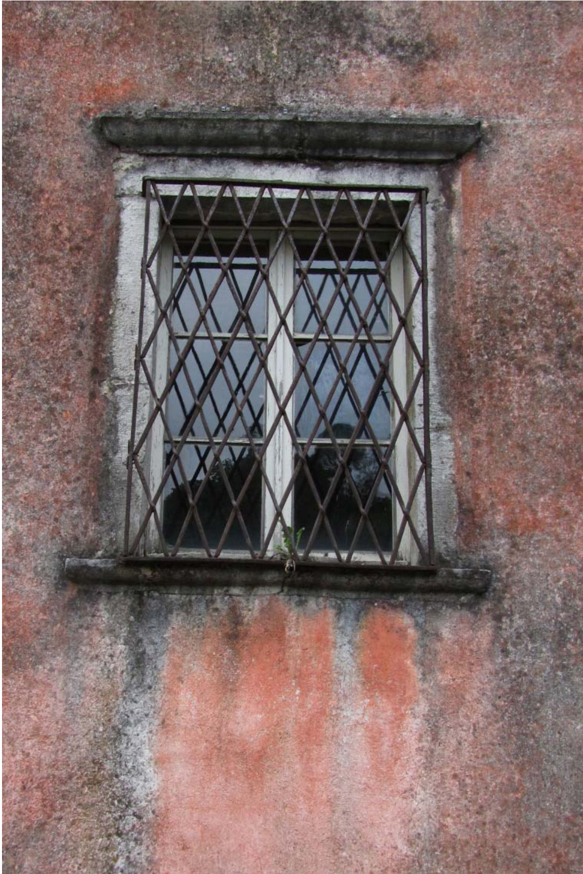
Cette maison que nous venons de dépasser allant sur le chemin de l'église, a quand même une fameuse couleur !
