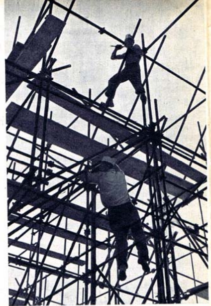
L'enchevêtrement de l'immense construction tubulaire dessine une belle composition dans le ciel.
