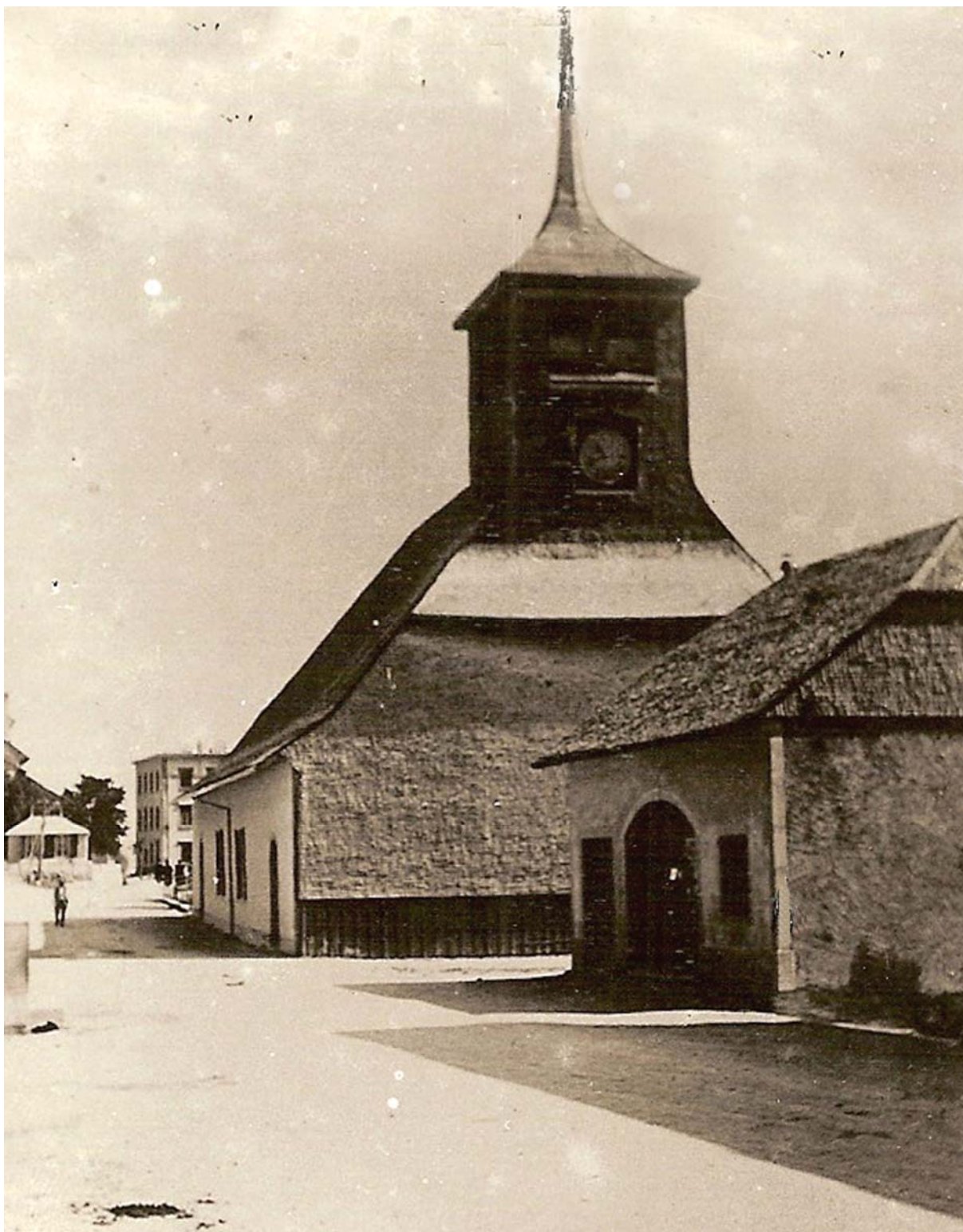
L'église du Sentier que fréquenta le pasteur Vuilleumier en 1930. Il évident que les bâtiments que l'on aperçoit dans le fond, Tempérance et local annexe de la pension Guignard-Vidoudez, n'existaient pas encore. Idem probablement pour le local des pompes à droite de la photo.
