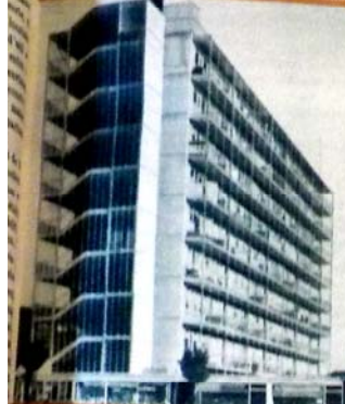
Hautes maisons à plusieurs étages avec de petits appartements individuels et un jardin. C'est un projet pour la reconstruction de Lorient.
