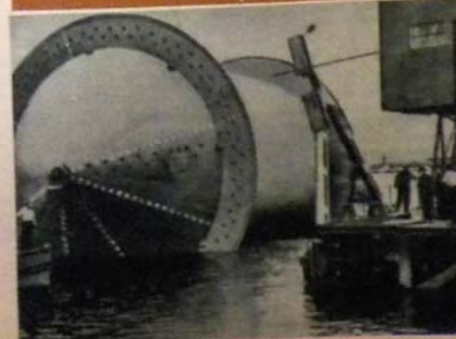
En France, construction du pipe-line relié à celui qui traverse le Manche. D'énormes bobines de câbles supportent les canalisations sous-marines. En voici une photographiée à Southampton, lors de la pose du pipe-line.
