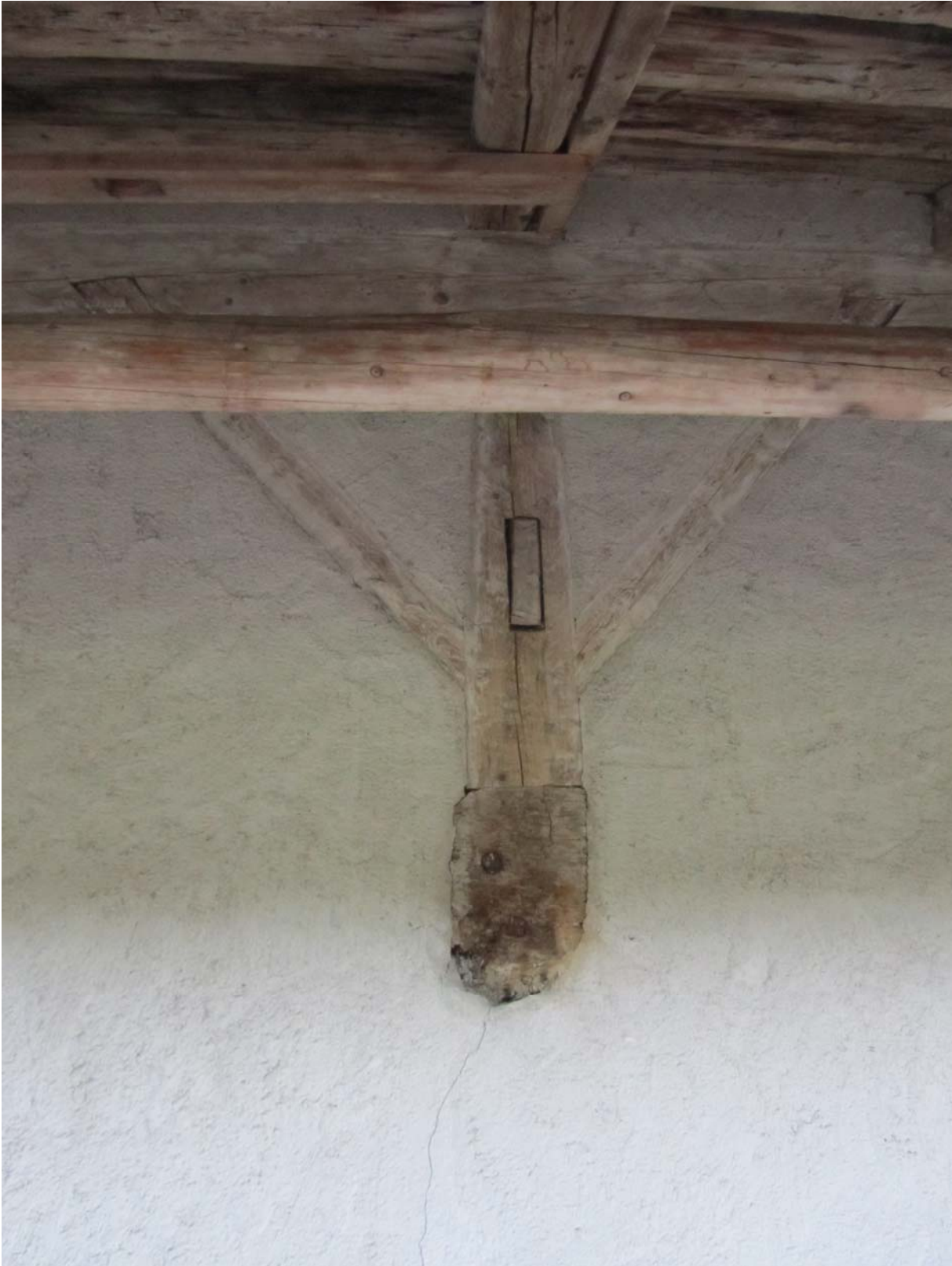
Un élément de la charpente qui apparaît sur le crépi actuel.
