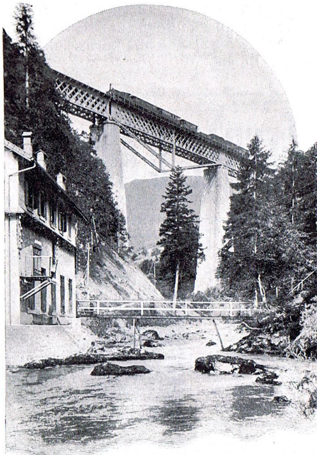
Le viaduc du Day et usine du Châtelard. (Phot. C. P. N.)
