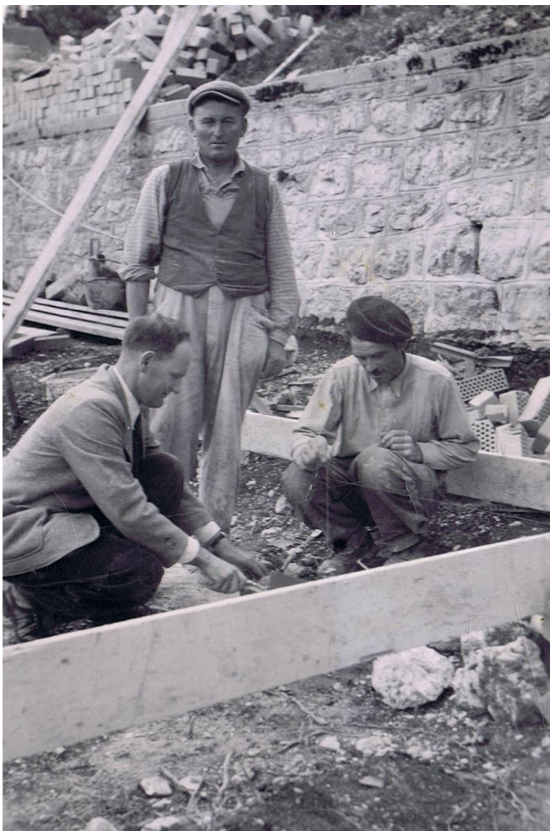
Ils travaillent à la construction de notre Hôtel de Ville.
