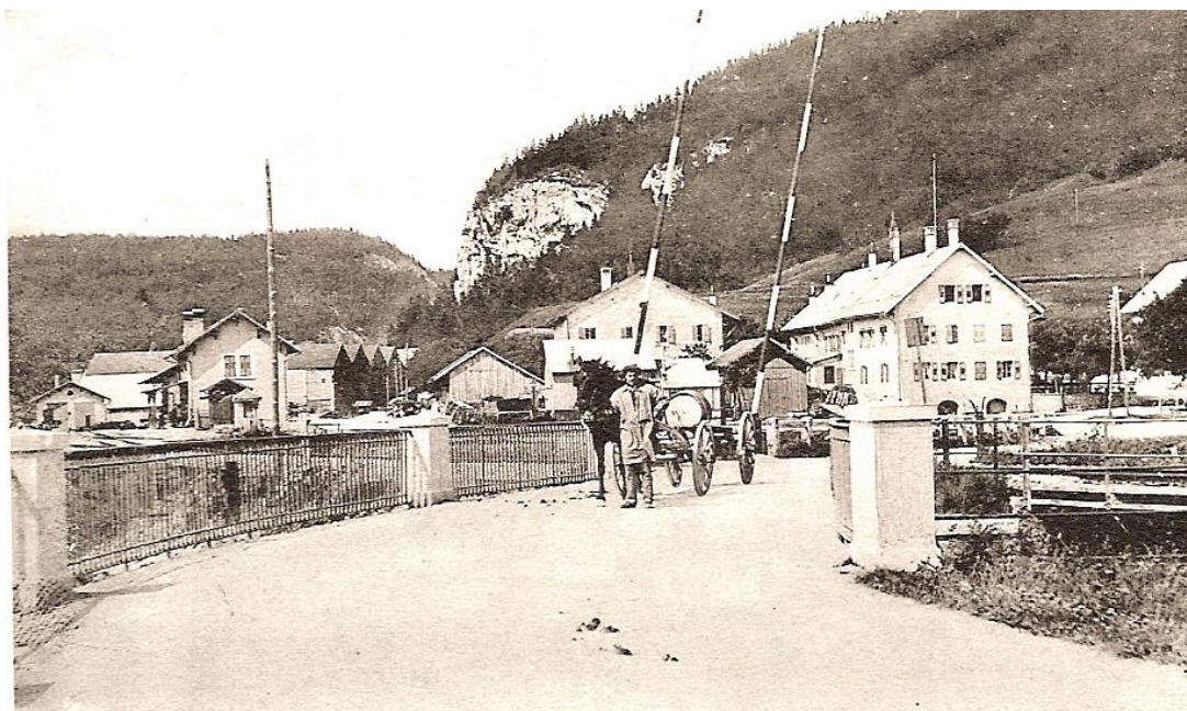
Le nouveau pont routier de la Goille. Passage à niveau et ligne du Pont-Brassus en retrait. Ces pont routier et ligne de chemin de fer, auront été reconstruits deux ou trois fois.
