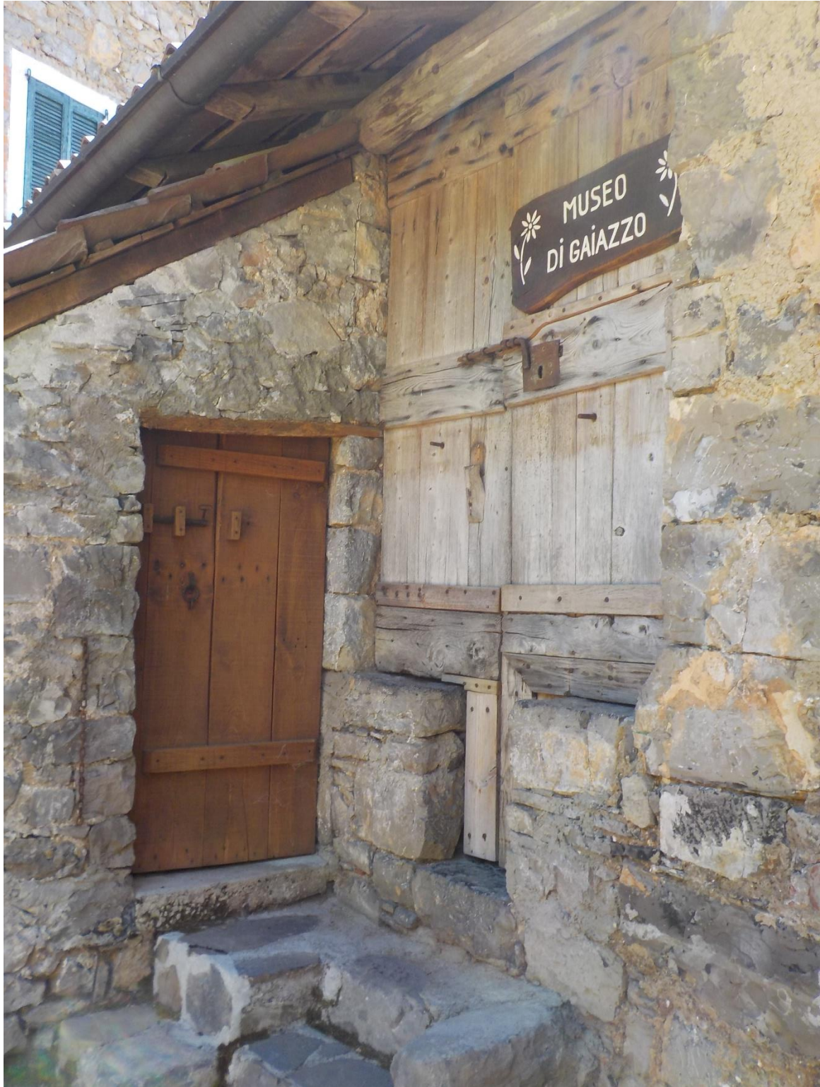
Porte de la grange, pour une première partie.
