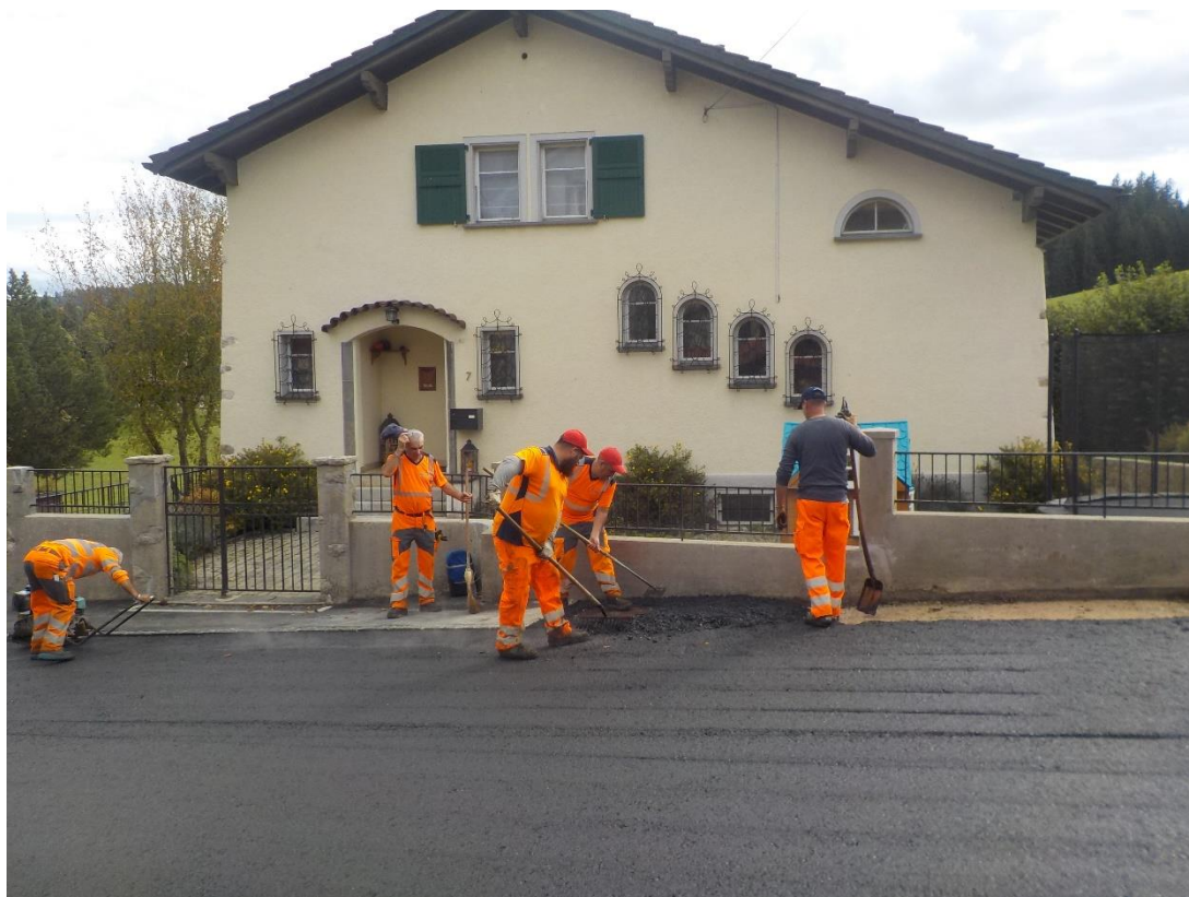
Pelles et brouettes pour les endroits que la grosse mécanique n'a pas pu atteindre.
