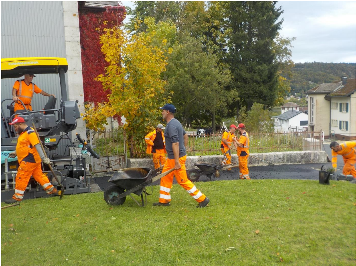
Une armée s'active. Le goudron est pris au camion à l'arrêt sur la gauche de la machine.
