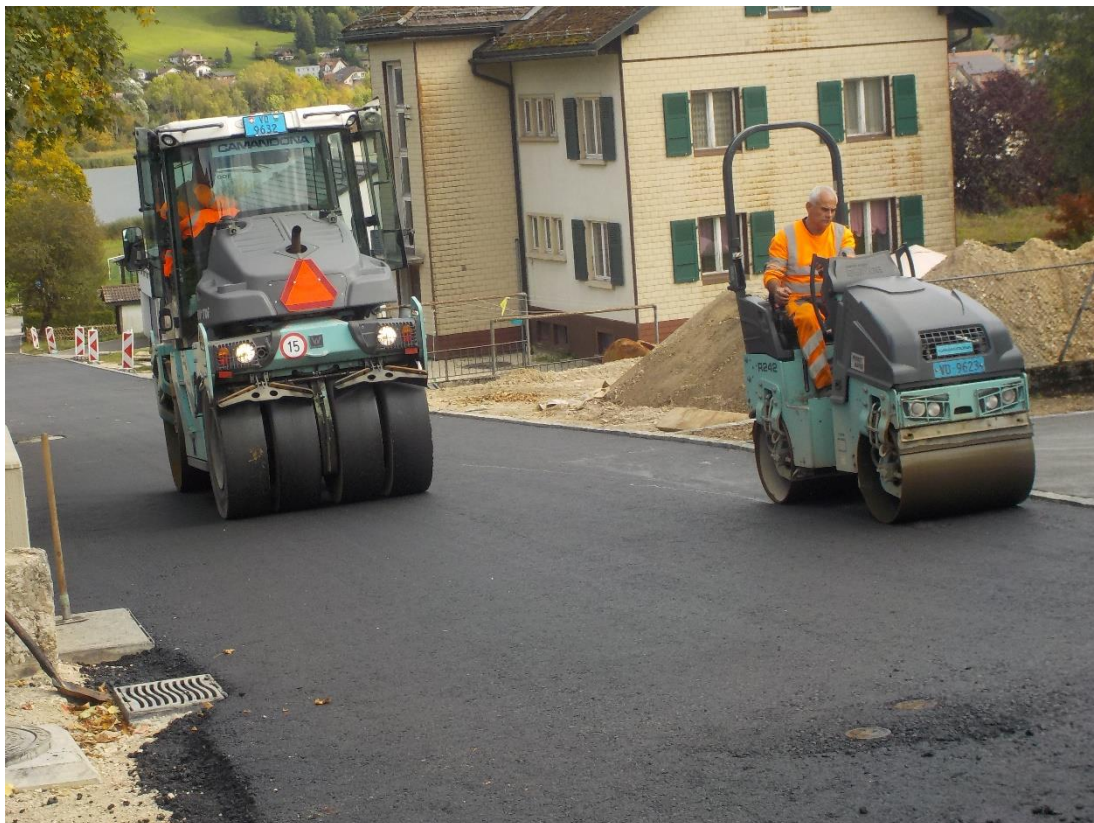
Derrière suivent les rouleaux compresseurs et le « tape », pour les entourages des grilles.
