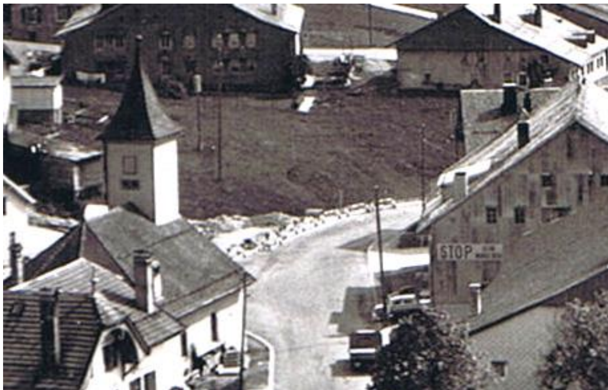
Place du Cygne. On découvre sur cet extrait l'importance des travaux. A gauche c'est toujours le vieux Cygne. STOP, ici on mange bien, telle était l'enseigne de Palmyr.
