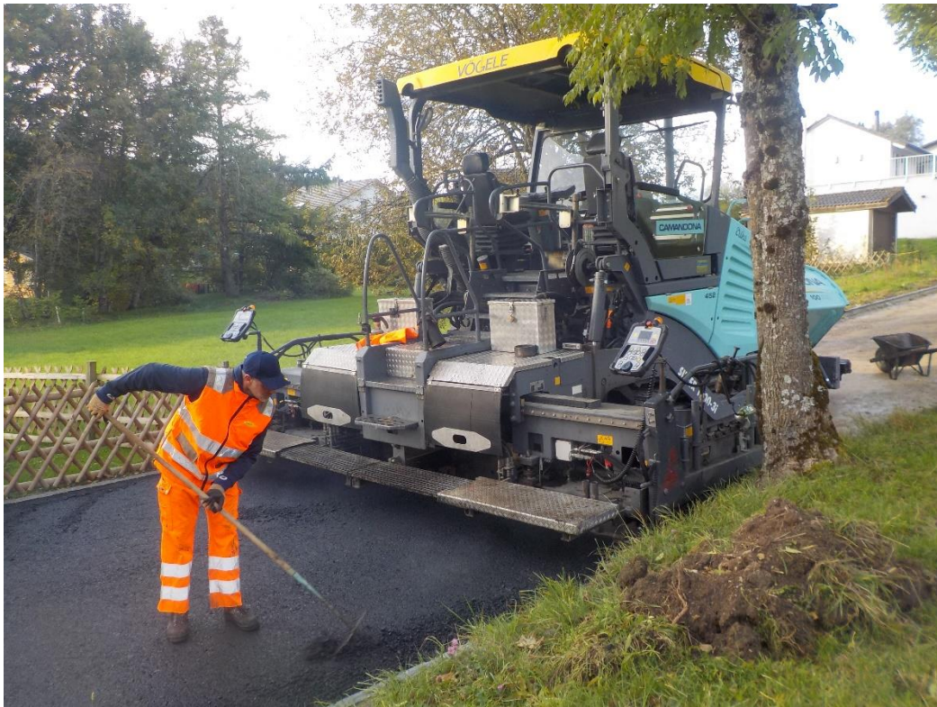
La machine crache son goudron. Bien étaler dans les bords.
