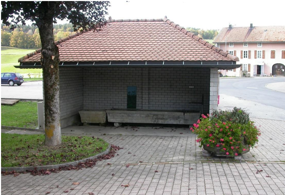
Le bassin avant sa démolition.
