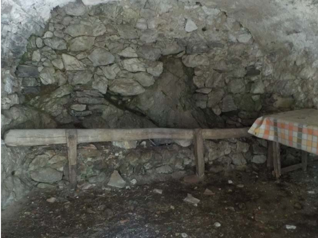
Les écuries ne servent plus depuis des lustres. Elles servent de dépôt.
