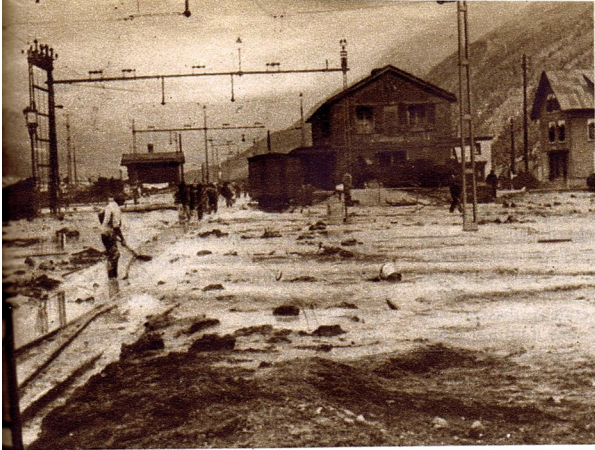
Dans les Grisons, enfin, et plus précisément dans l'Engadine, des pluies torrentielles ont également causé pas mal de dégâts. Voyez plutôt le triste état de la gare de Celerina. (A. T. P. VI Bu 16220.)
