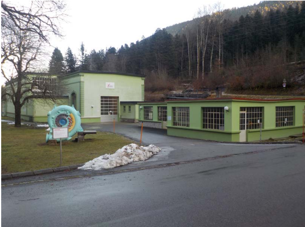
L'usine électrique de La Dernière utilise les eaux des lacs de Joux et Brenet.
