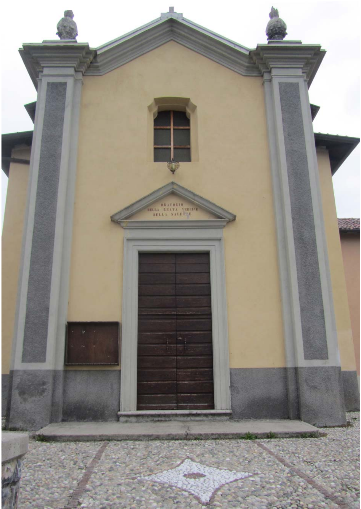
Construite autrefois avec l'aide des gens du village.
