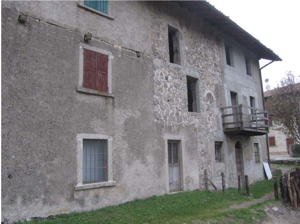
Des arrières peu engageants. Façade située plein nord, il y a peu de chances pour que la maison se voie un jour restructurée.
