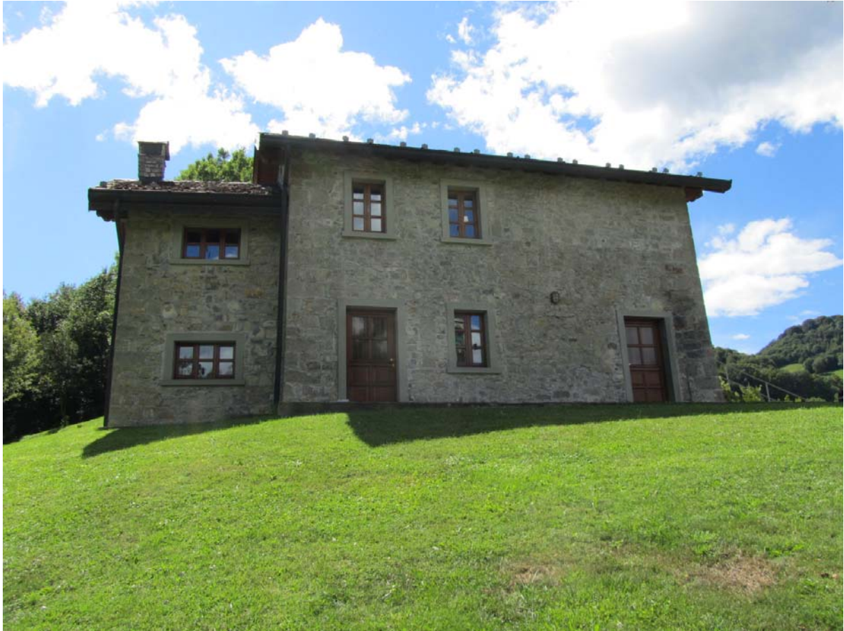
Une restauration récente en bonne et due forme, simplement peut-être un peu trop excessive.
