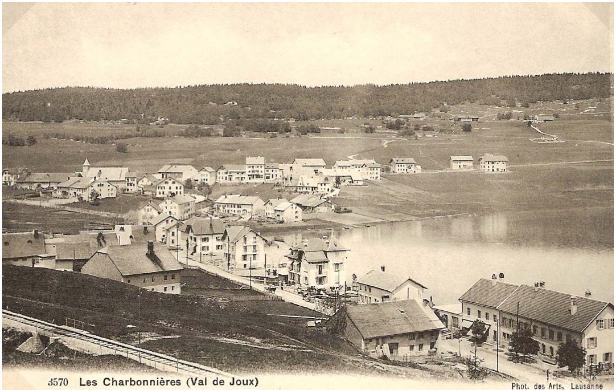
Vers 1906. Le lac toujours dans sa plus grande extension et parfaitement rempli malgré désormais l'évacuation des eaux par canal artificiel.
