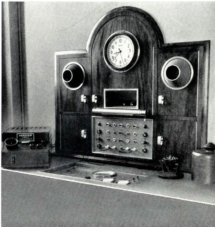
Ensemble de l'installation au local de contrôle de la marche des montres et horloges.
