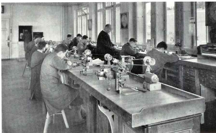
Atelier des ébauches, remontoirs et mécanismes compliqués Toutes les machines sont commandées individuellement par de petits moteurs construits à l'école.
